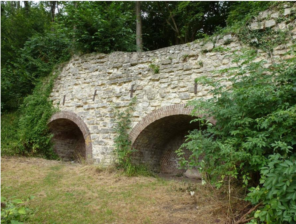
Foto: Kalkovens Daelsweg, Putberg.
