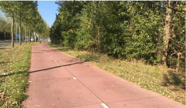
Fietspad in beton, roodbruin
