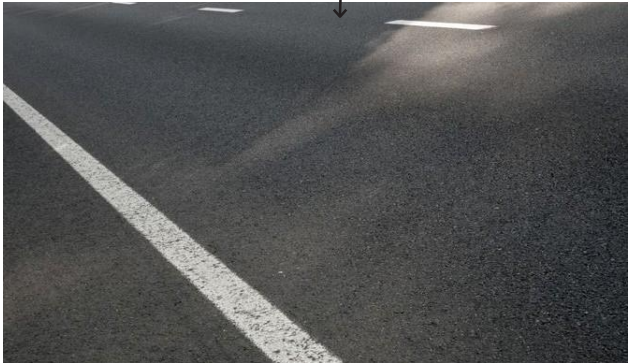
Rijbaan N595 in asfalt Perron bushalte in klinkers
