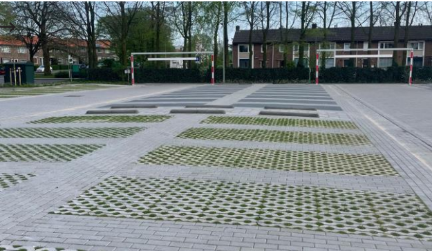
Rijbaan overloopparking in grastegels/ betonklinkers PP overloopparking in grastegels
