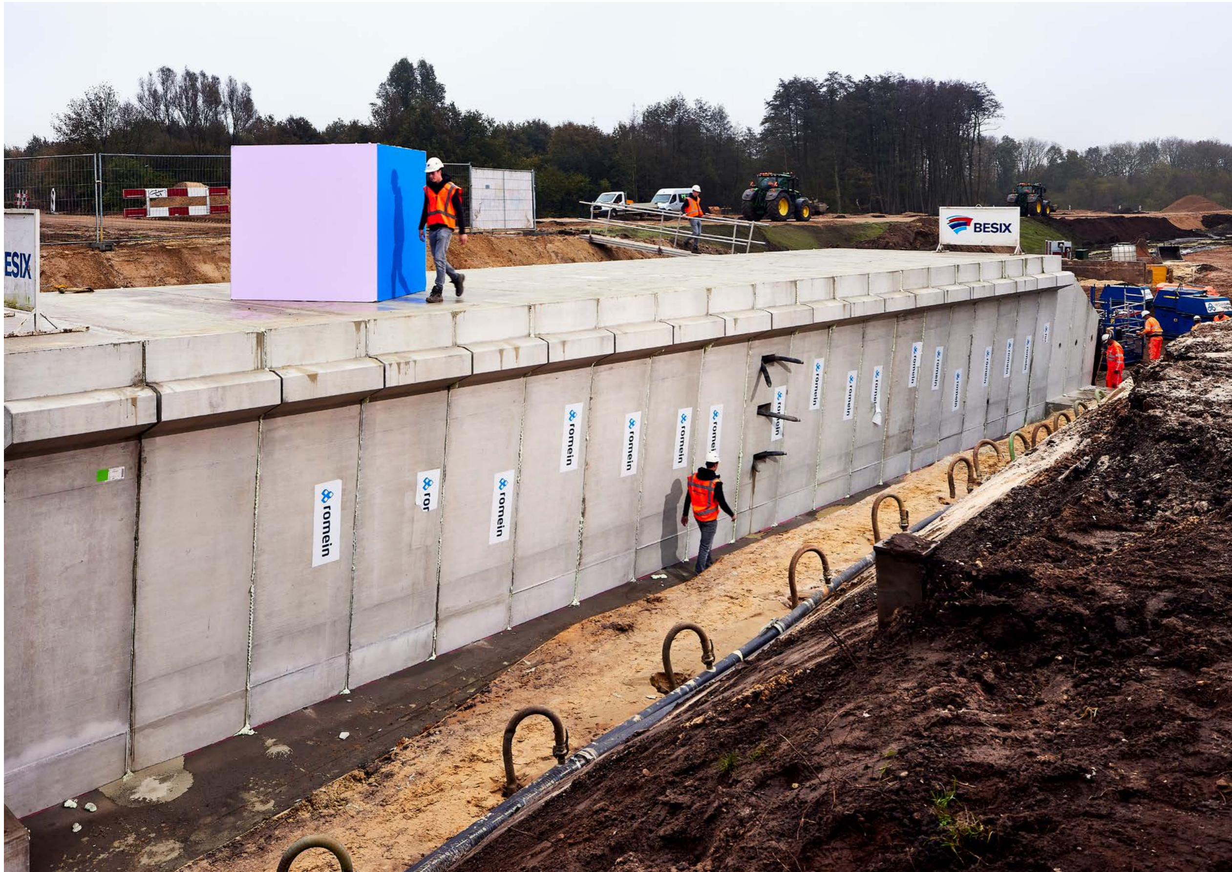
Kansen voor wegenbouw. Provincie Limburg renoveert de N270 in de omgeving van Venray. Zo verbeteren we de veiligheid en doorstroming.
